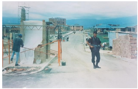
Construcción de entrada y guardia .1997
