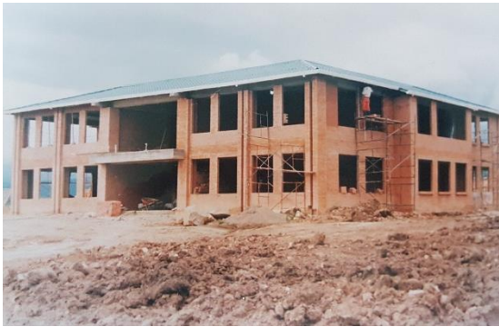
Construcción Bloque de Aulas. 1996
