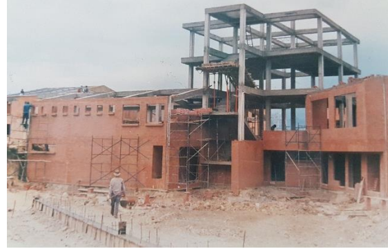
Construcción bloque administrativo. 1996
